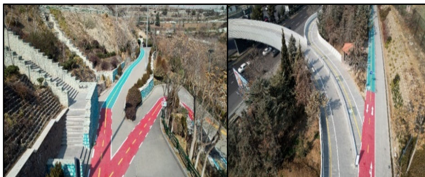
شکل ۷- مسیرهای مشخص شده با خط‌کشی و علائم راهنمایی، بخش خوانایی و معناداری فضا.
